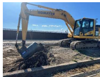
写真 7 大型土嚢詰め込みバケット使用状況
