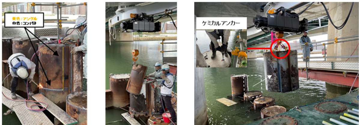
図 6.鋼管・中詰コンクリート撤去状況（気中部）
