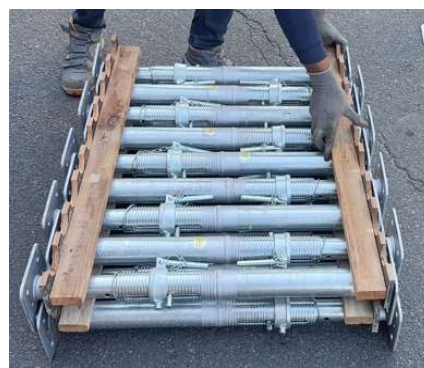
積み上げ状況（2段目）
