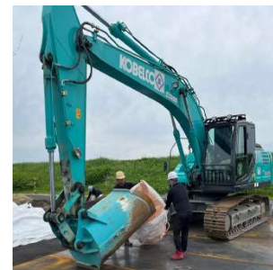
写真 5 土嚢詰め込みバケット
