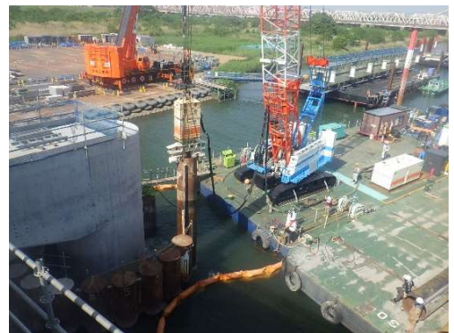
図 1.標準工法による施工状況
