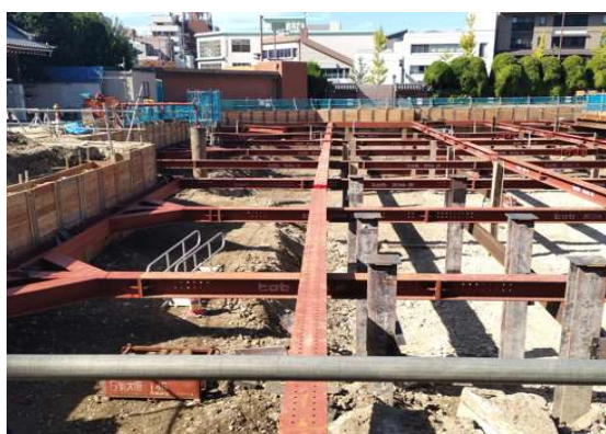
施工後の様子①（切梁）
