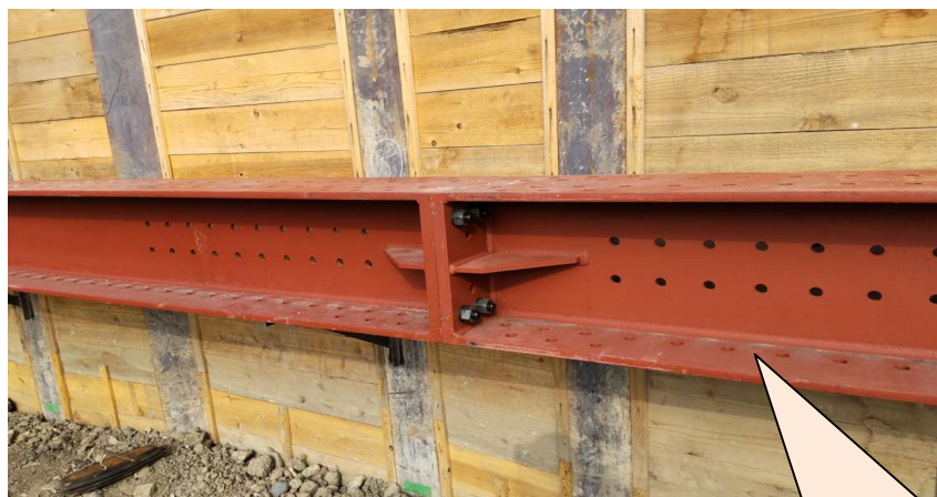
新工法の継手箇所（参考）
