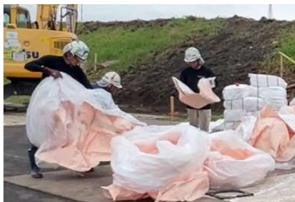
写真 1 内袋折り返し、整形作業状況
