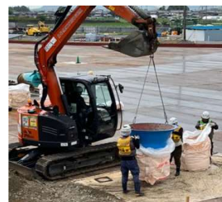
写真 2 ジョーゴによる詰め込み状況
