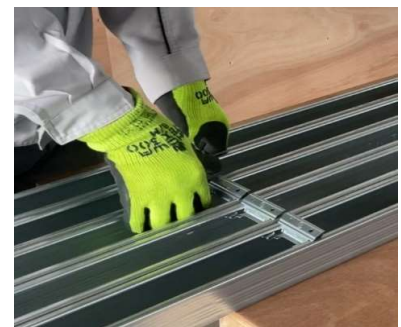
スペーサー取付状況
