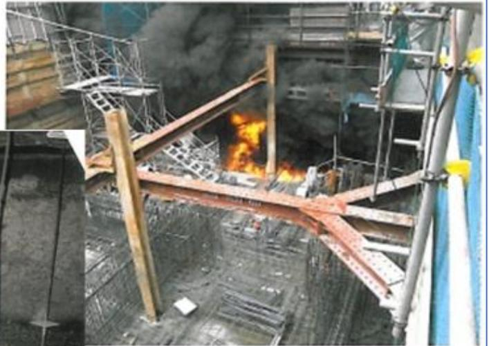
地下基礎工事中、型枠建込用のセパ受け金物を溶接取付中、レベルコンクリート下に打ち込んでいた発泡スチロールに引火した。
