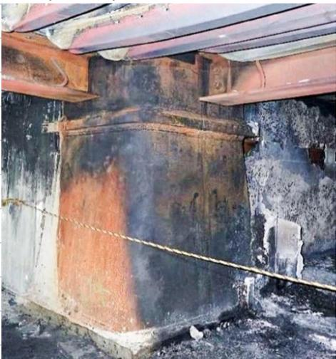
建替え工事中の地方公共団体庁舎(25階建て)において、24階の人荷用エレベーターロビーで天井の鋼板をガスバーナーにより切断した際、天井裏に敷き込んであった断熱材（ポリスチレンフォーム）に着火し燃焼した。可燃物である断熱材が目視できない場所でガス切断作業をしたことが要因(当該地方公共団体発表)。火災発生時、24階には10人の作業員がいたが負傷者はいなかった(報道発表)。
