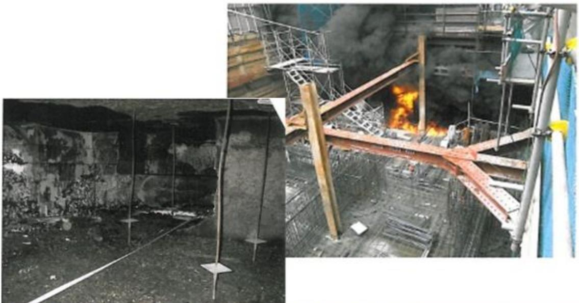
地下基礎工事中、型枠建込用のセパ受け金物を溶接取付中、レベルコンクリート下に打ち込んでいた発泡スチロールに引火した。
