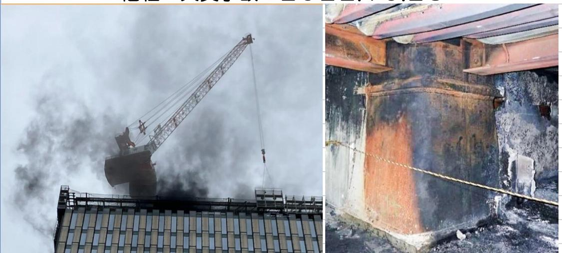
建替え工事中の地方公共団体庁舎(25階建て)において、24階の人荷用エレベーター口で天井の鋼板をガスバーナーにより切断した際、天井裏に敷き込んでいた断熱材（ポリスチレンフォーム）に着火し燃焼した。可燃物である断熱材が目視できない場所でガス切断作業をしたことが要因（当該地方公共団体発表）。火災発生時、24階には10人の作業員がいたが負傷者はいなかった（報道発表）。
