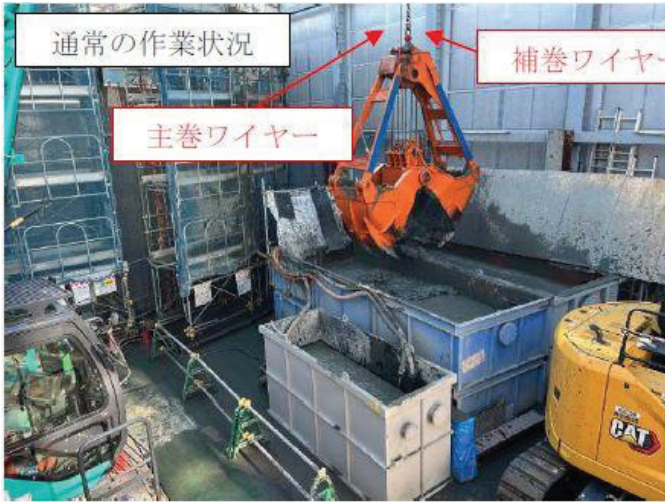
写真. ドレッチャーバケツによる揚土状況(土砂ピット)
