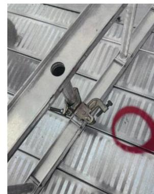
写真B: 梁から外れた上部キャッチクランプ
