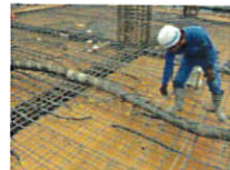
③閉塞箇所確認
