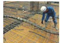
③閉塞箇所確認
