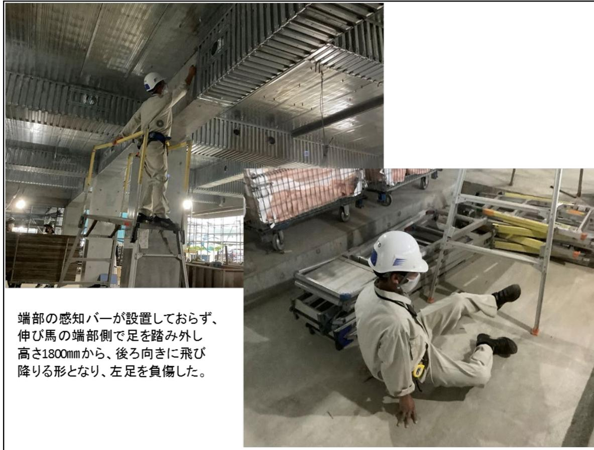
端部の感知バーが設置しておらず、伸び馬の端部側で足を踏み外し高さ1800mmから、後ろ向きに飛び降りる形となり、左足を負傷した。
