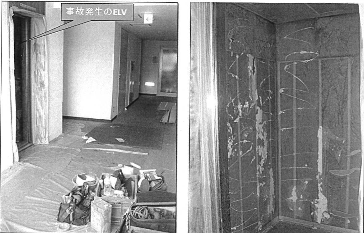
事務所テナントビルのELV内装改修工事において、作業員2名がELVカゴ内で剥離剤を用いて内装シートを剥がす作業中、エレベーターかご扉を閉じてかご内の換気を行っていない作業環境で、剥離剤に含まれた有機溶剤が揮発し吸い込み、2名の作業員がELVかご内床にうつ伏せに倒れた状態で発見された。有機溶剤中毒になったものと思われる。
